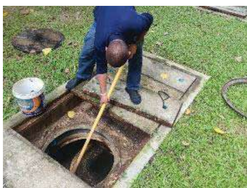
การตักไขมันออกจากกระบบบำบัดน้ำเสีย
