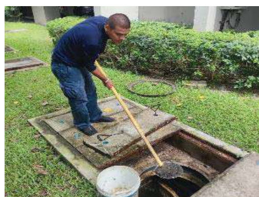
การตักไขมันออกจากกระบบบำบัดน้ำเสีย
