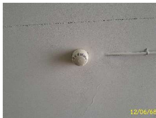
อุปกรณ์ตรวจจับควัน (Smoke Detector)
