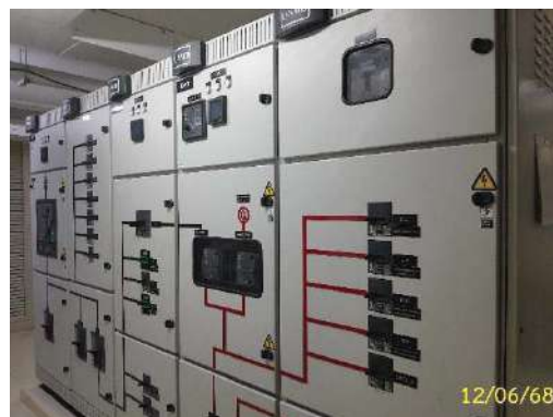
ตู้ควบคุมไฟฟ้าหลัก (MDB)
